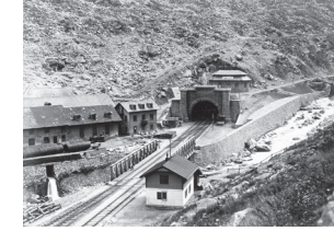
Inaugurazione della galleria del San Gottardo
